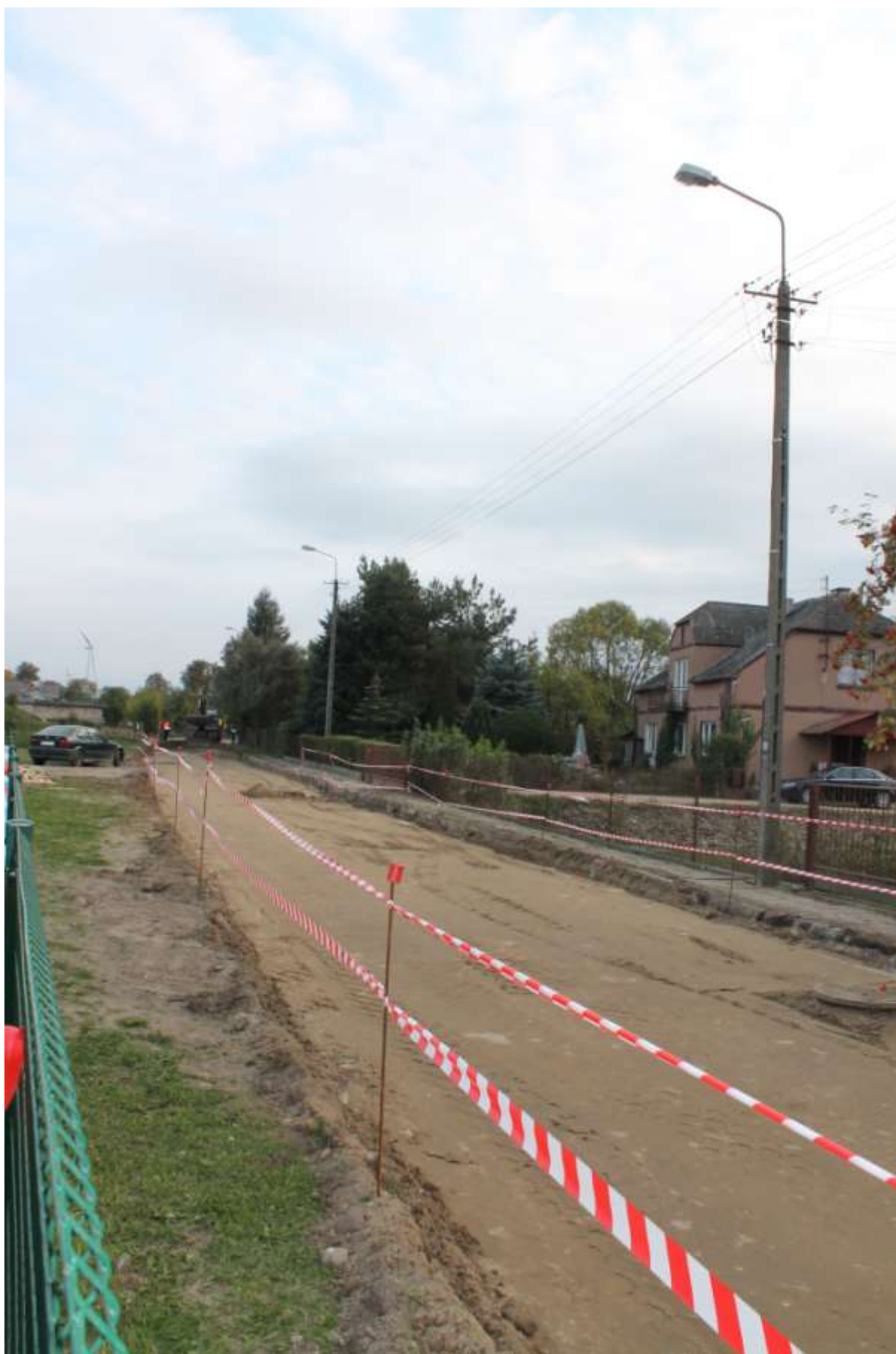
Przebudowa dróg gminnych
