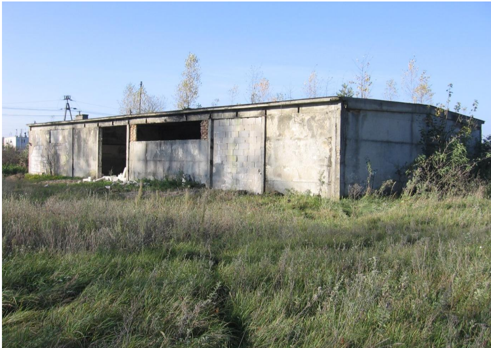
Rysunek 4. Magazyny byłego PGR, które zostały zaadaptowane na świetlicę wiejską
