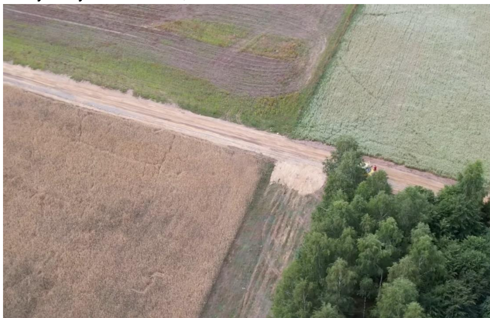
fot. przebudowana drogi w Murawkach
