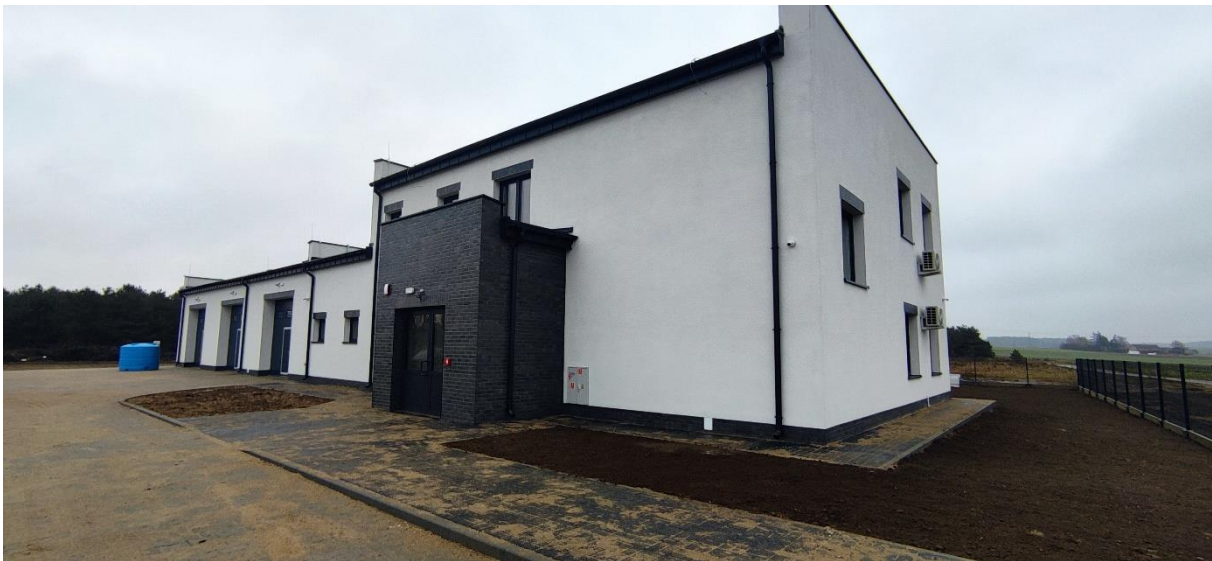
fot. Budowa budynku warsztatowo-magazynowego
