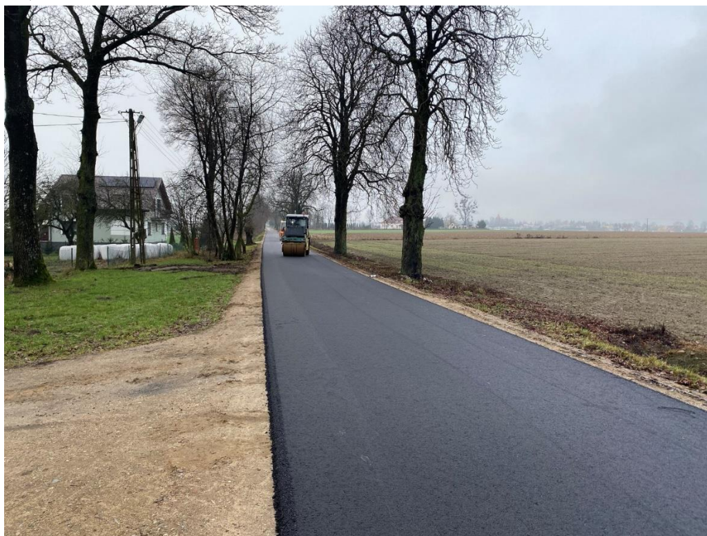
fot. przebudowana drogi w Wielkim Łęcku
