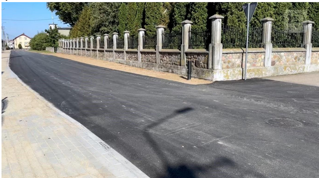
fot. przebudowana drogi w Niechłonie
