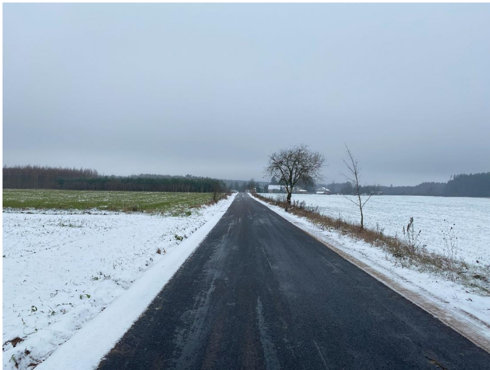
fol. przebudowana drogi w Zalesiu
