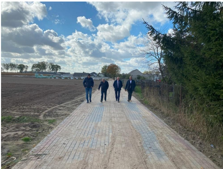
fot. przebudowana drogi w Jabłonowie
