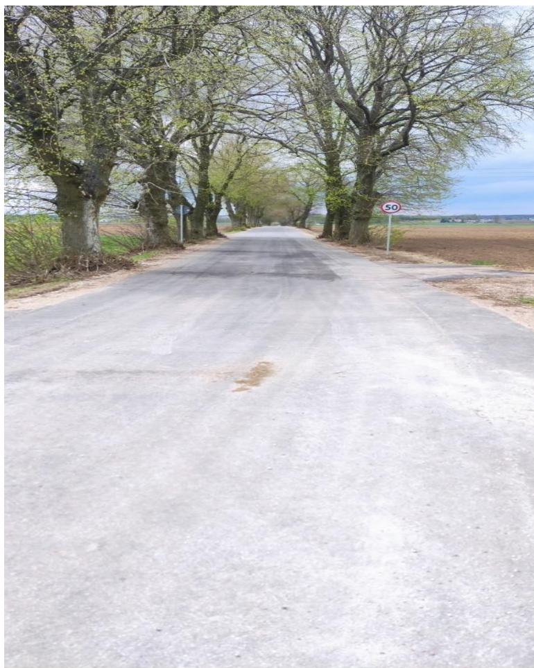
foto. przebudowana drogi w Galewie
