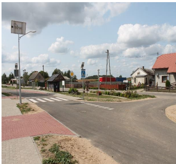
Fot. przebudowana droga w Małym Łęcku
