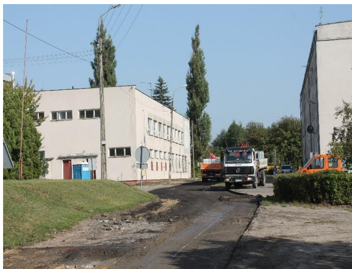
fot. Droga w Gródkach w trakcie przebudowy
