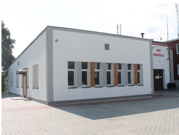
Fot. Remiza OSP w Płońnicy po termomodernizacji
