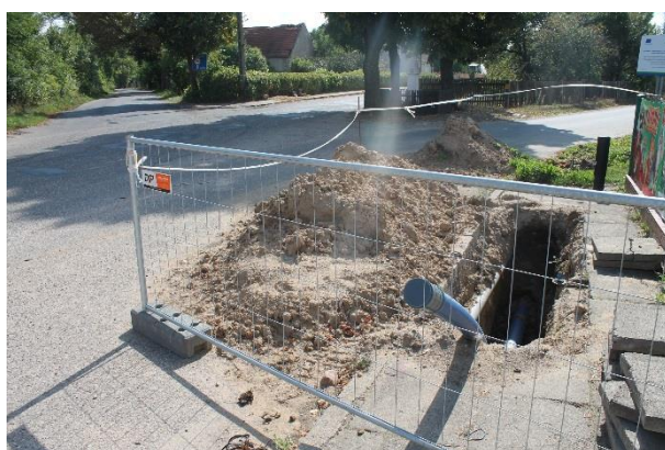
Fot. wymiana sieci wodociągowej w Płośnicy
