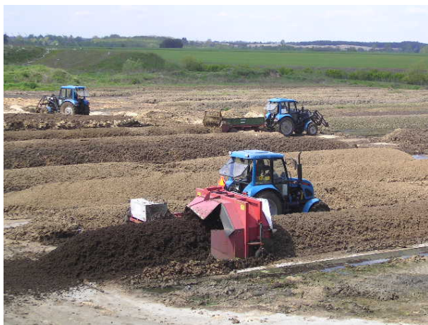
Rys. 60. Kompostownia w Zakrzewie źródło: Ekologiczny Związek Gmin „Działdowszczyzna”
